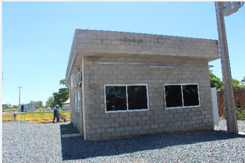
Abrigo do polímero e painéis
