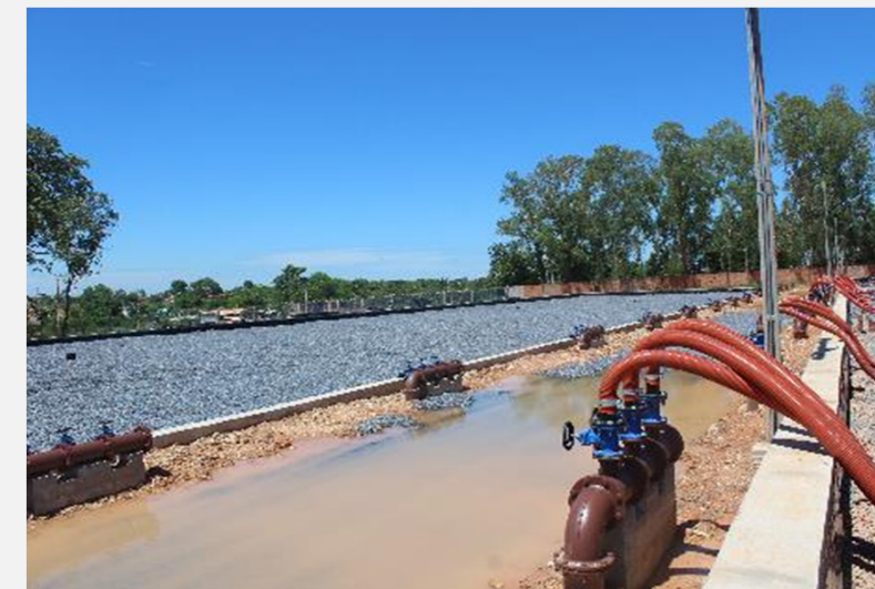
Área de contenção dos bag's.
